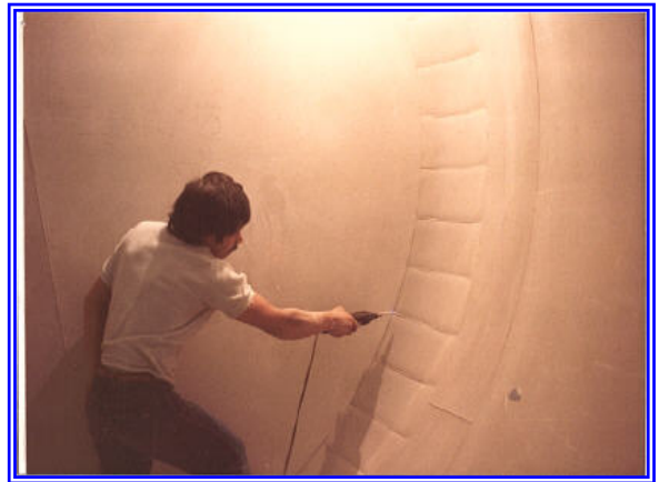
Prueba de hermeticidad de soldaduras al 100%
