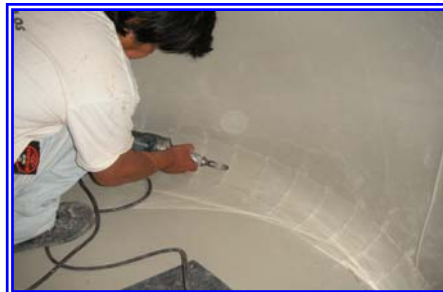
Pulido de soldaduras interiores
