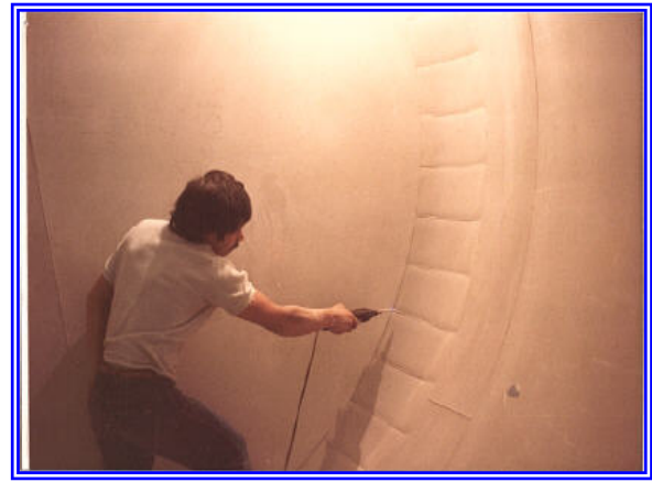
Prueba de hermeticidad de soldaduras al 100%
