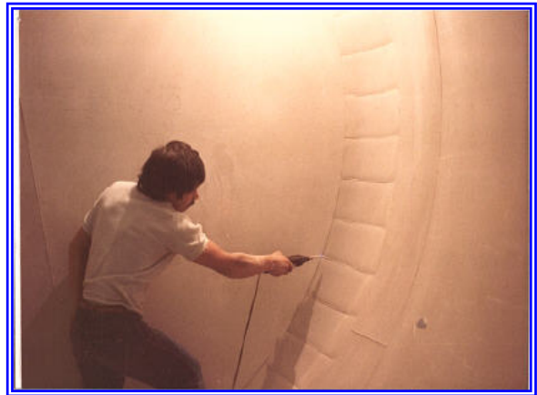
Prueba de hermeticidad de soldaduras al 100%
