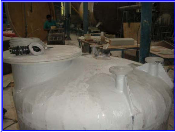
Refuerzo exterior del PP con FRP
