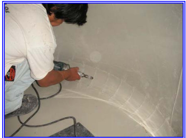
Pulido de soldaduras interiores
