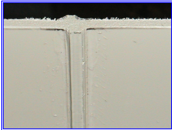
Detalle de cordón de soldadura interior y exterior
